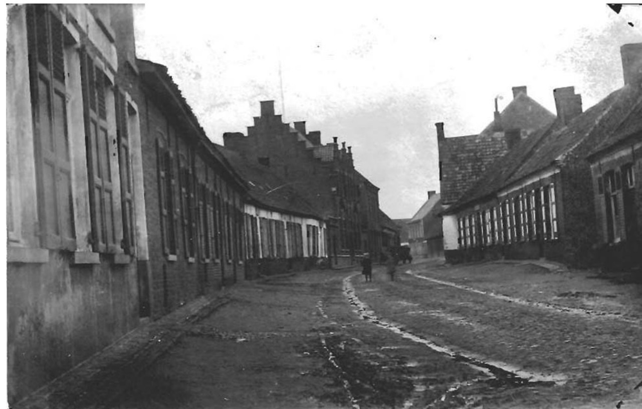
1564 SCHUIFERSKAPELLE, H. d' Hontstraat, op de linker kant herkenbaar gebouw van pastorie met trap(zij)gevels gebouwd in 1907 in neogotische stijl
